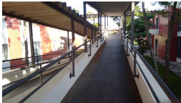
Figura 5 - Rampa. Fonte: Dos autores, 2014.
