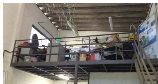
Figura 2 – Cobertura do Centro de Triagem. Fonte: Levantamento Fotográfico das Autoras.
