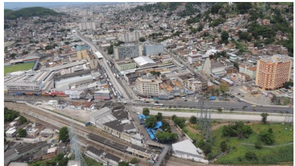
Figura 1: Impacto na paisagem de trecho de bairro na Zona Norte da Cidade no Rio de Janeiro, após obras viárias de grande porte.
