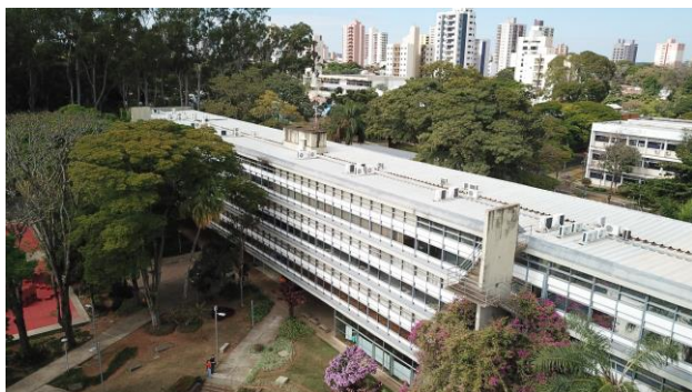
Figura 1: Vista aérea do Edifício E1. Fonte: Autores.
