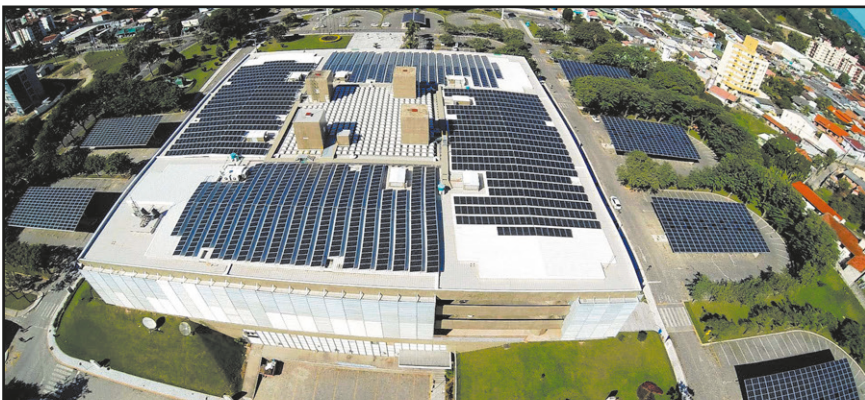
Figura 1.18 Usina Megawatt solar da Eletrosul em Florianópolis, SC (Eletrosul, 2014)
