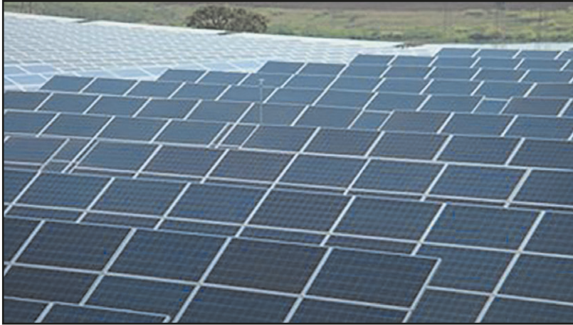
Figura 1.17 Usina Solar de Tanquinho da CPFL Energia em Campinas, SP (CPFL Energia, 2011)
