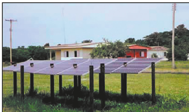
Figura 1.13 Sistema de eletrificação fotovoltaica do Núcleo de Perequê (Vale do Ribeira - SP) (IEE, 2000)
