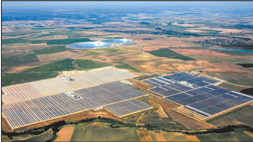
Figura 1.16 Maior usina de geração FV no Brasil. 321 MW (Solis Energia, 2017)
