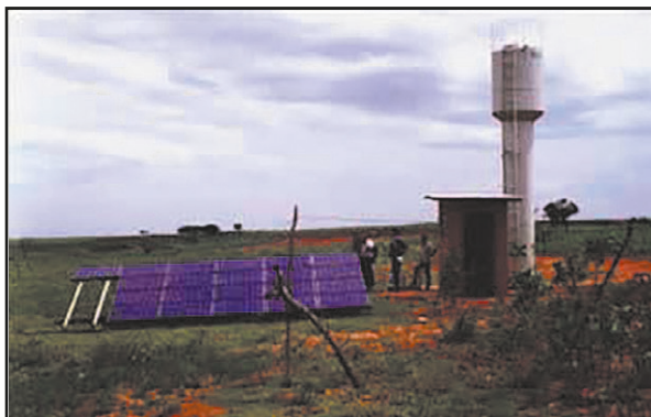
Figura 1.12 Sistema de bombeamento fotovoltaico de Santa Cruz I (IEE, 2000)
