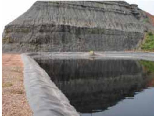
Figura 4.9 Tanque a partir do qual era bombeado o lixiviado até o divisor de águas do aterro.
