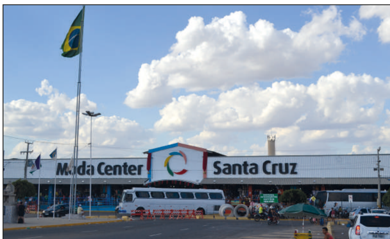
Figura 43 – Vista frontal do “Moda Center Santa Cruz”.
