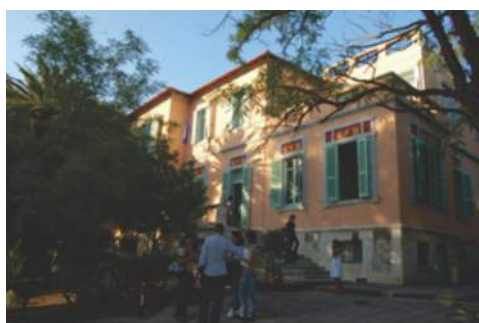
Fig. 5 Villa Satta, la storica sede dello IED a Cagliari.
