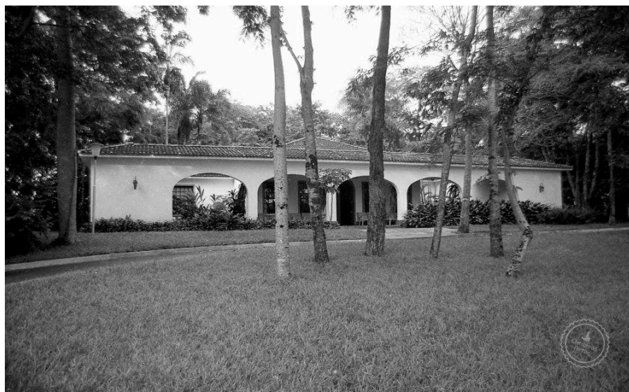
Figura 2: Casa de Visitas de Furnas, 1983 (Fonte: Acervo Furnas)
