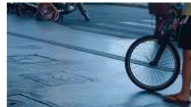
Figura 22 – Falta Piso direcional e alerta
