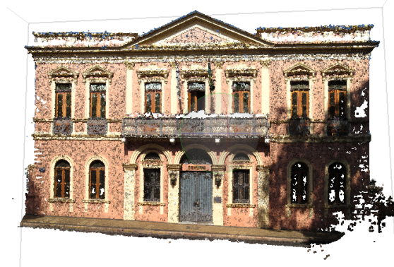
Figura 3. Nuvem de pontos gerada por meio da fotogrametria da fachada do Palacete Bento Carlos. Fonte: Autores, 2022.
