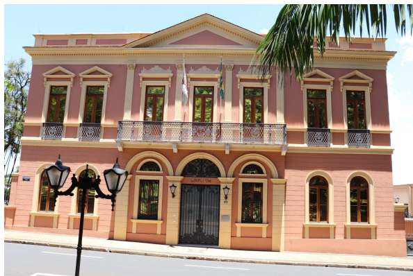
Figura 1. Fachada do Palacete Bento Carlos. Fonte: Autores, 2022.
